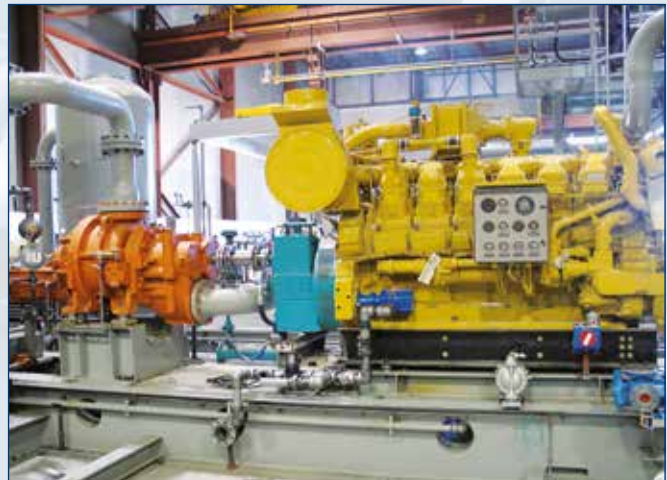
Pumpenantrieb / Pump drive
