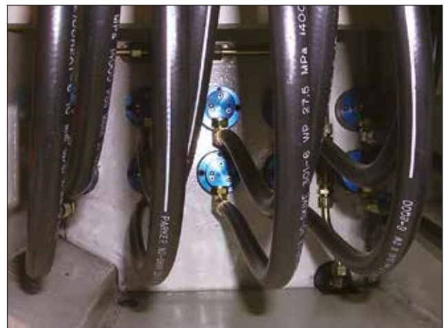
Deublin 1117 lagerlose Drehdurchführung an Transferstraße
