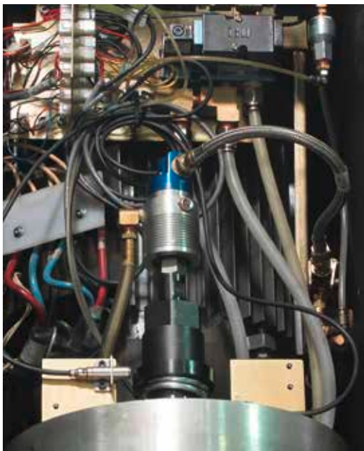
Deublin 1109 auf vertikalem Bearbeitungszentrum.
